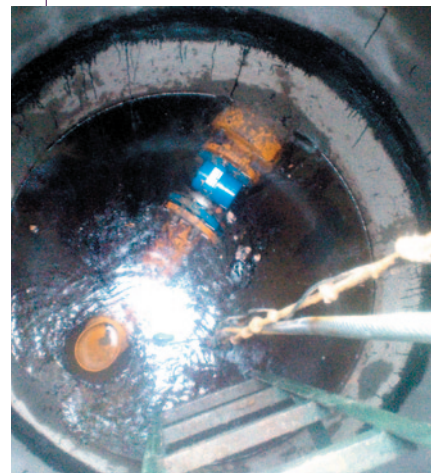
Установка электромагнитного расходомера в канализационном колодце
